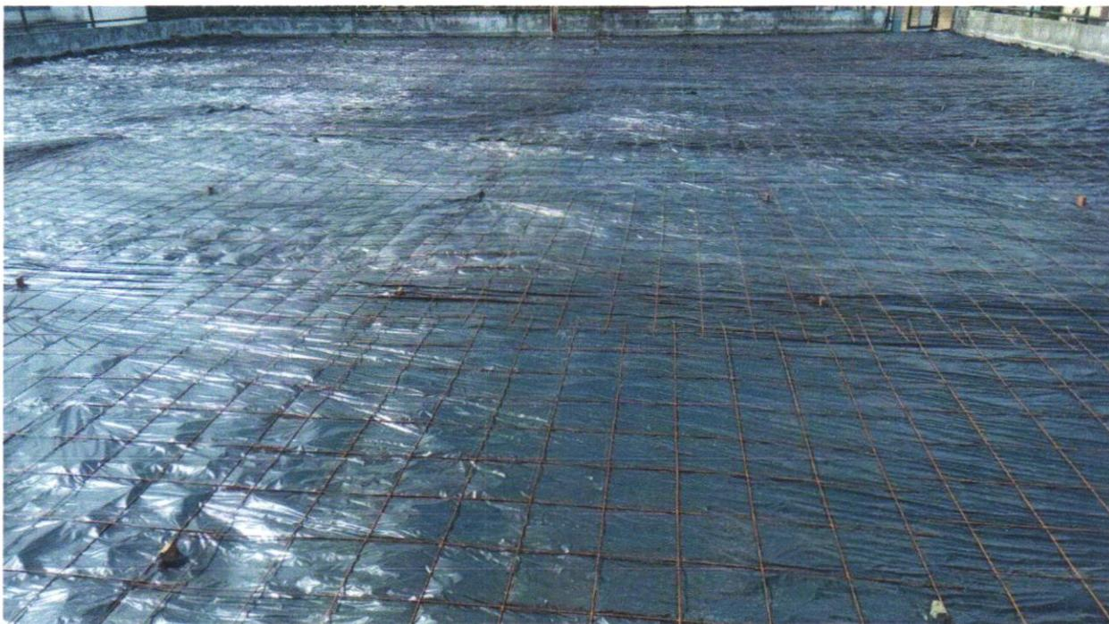
Foto 05 - FORNECIMENTO E INSTALAÇÃO DE TELA AÇO SOLDADA NERVURADA CA-60, MALHA 15X15CM, FERRO 4.2MM, PAINEL 2X3M, (1,50KG/M<sup>2</sup>), MALHA POP REFORÇADA GERDAU OU SIMILAR
